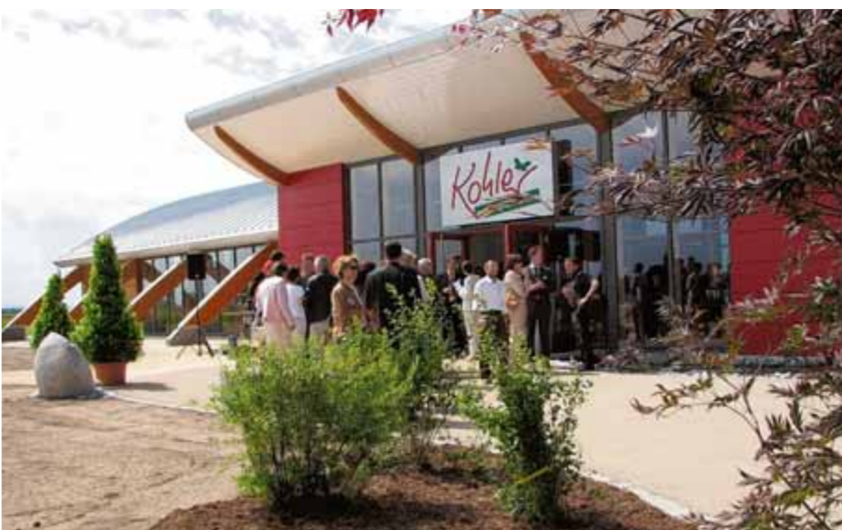
„Kohler – natürlich einrichten“ am Ortsrand von Erolzheim ist nach Angaben des Eigentümers Peter Kohler das erste Einrichtungshaus in Europa mit Passiv-Energiestandard.
